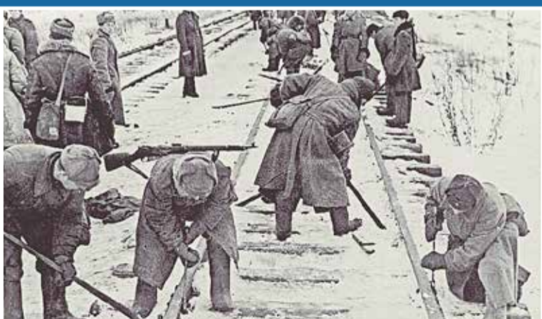
Ремонт железнодорожных путей между Урицком и Стрельной. 1944 год. архив кинофотодокументов
