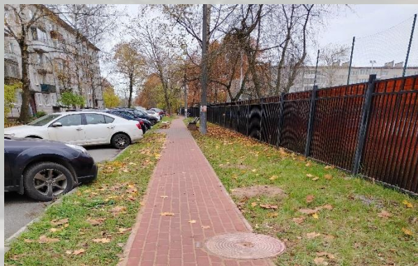
ул. Гоголя, д.9 (ремонт пешеходной дорожки)
