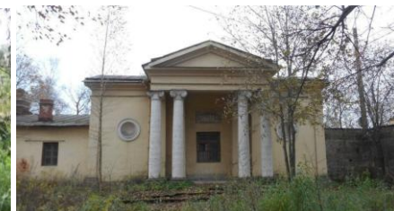
Здание с ионическим портиком и кузница
